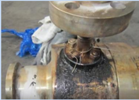
01 - 분해 전 LEAK POINT 확인
